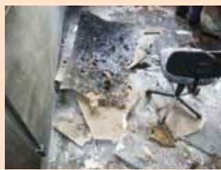
Sala foi totalmente destruída
